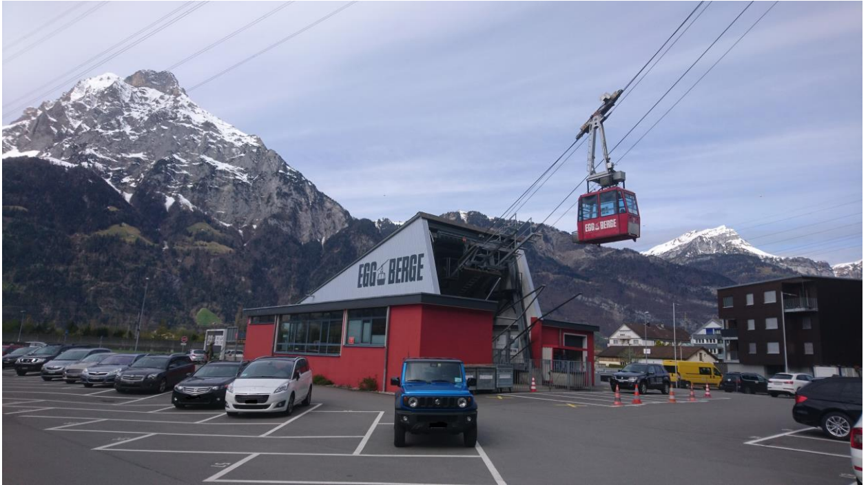
Talstation Seilbahn Eggberge Frühling 2021
